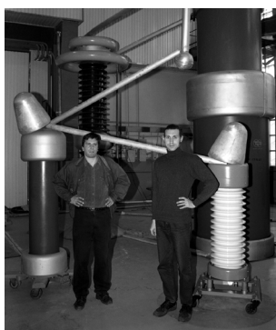
Рис. 1. КГИ-200 на высоковольтных испытаниях
